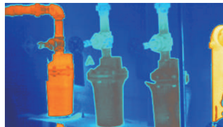
暖通空調檢修
